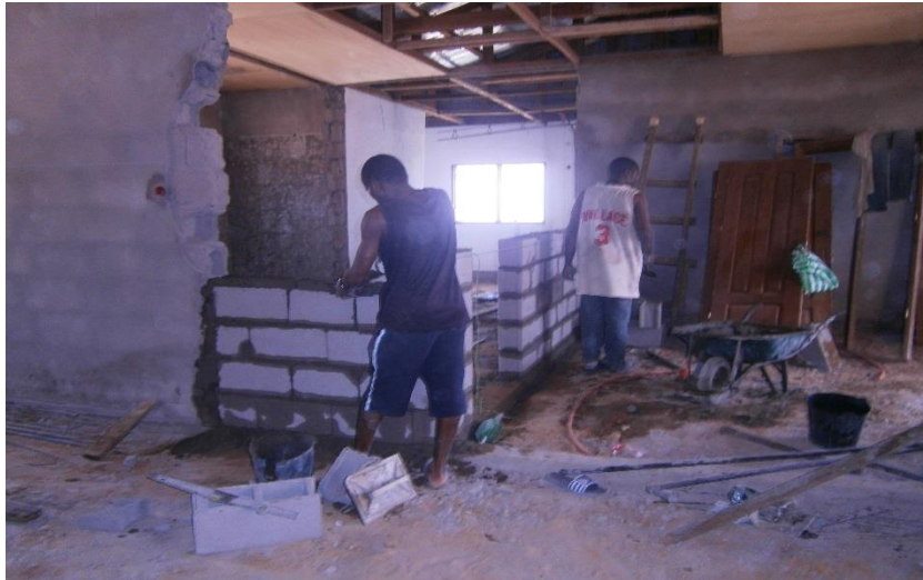
Foto 4. Inicio de las obras – interior
