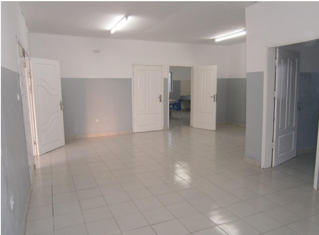
Foto 17. Distribuidor del edificio 1
