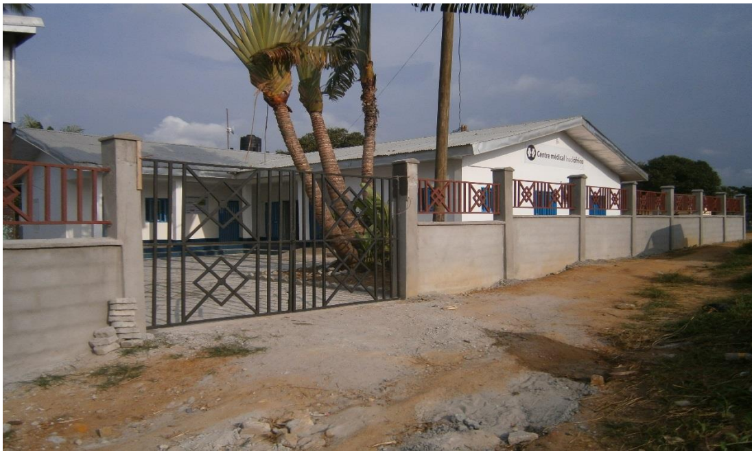
Foto 18. Finalización obras rehabilitación– Noviembre del 2017
