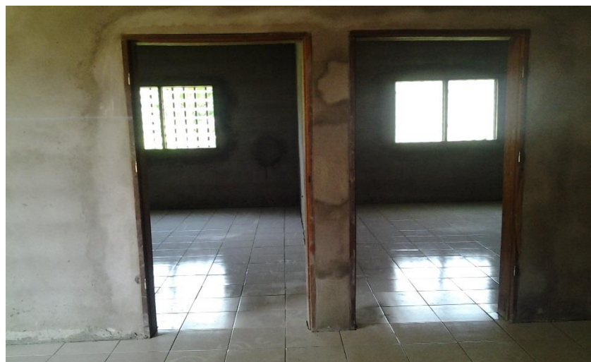
Foto 6. Inicio de las obras – interior
