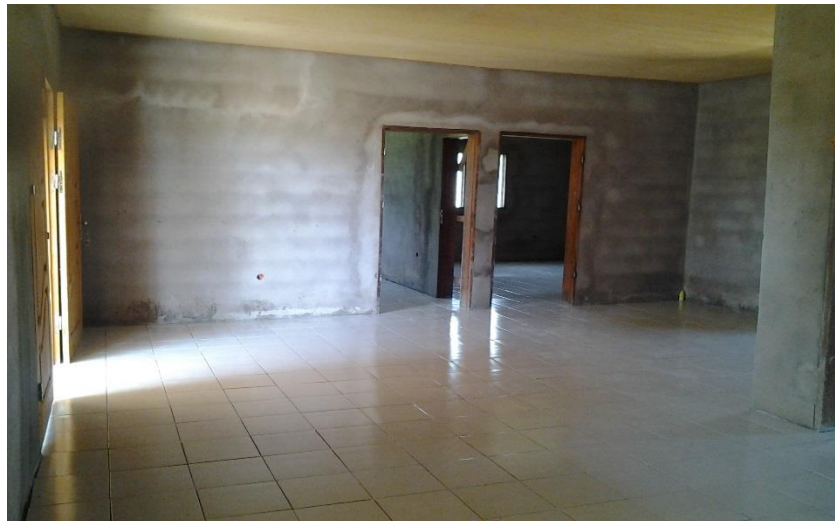
Foto 5. Inicio de las obras – interior
